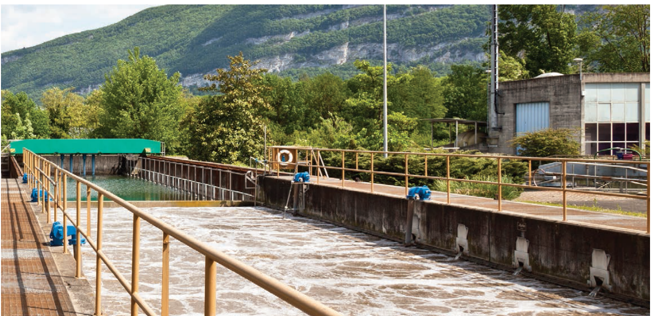
Bassins extérieurs de la STEP de Villette
