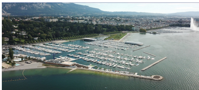
La fameuse « digue Nord » au premier plan
